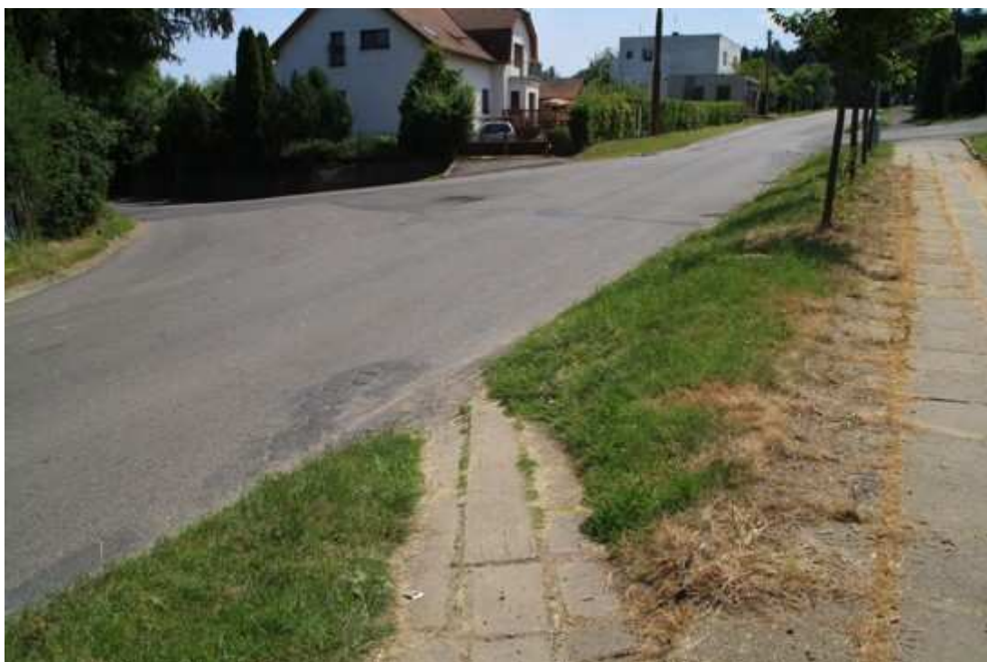
z ul. Hrdinů je patrný nájezd, který používají chodci i cyklisté, chodci se tomuto místu raději vyhýbají a volí lávku přes železniční trať
