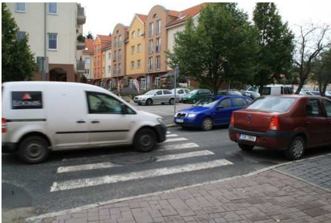
před obecním úřadem parkují vozidla, přes která nejsou děti vidět, tomuto je třeba zamezit zúžením vozovky na nezbytné minimum, například osazením chodníkůvých mysů
