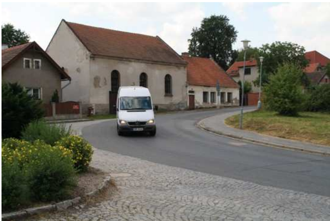
zatáčka na návsi Četníka J. Bojase – nákladní vozidla mají s protisměrným příčným sklonem mnohdy problém, nejvíce nehodové místo ve Strančicích
