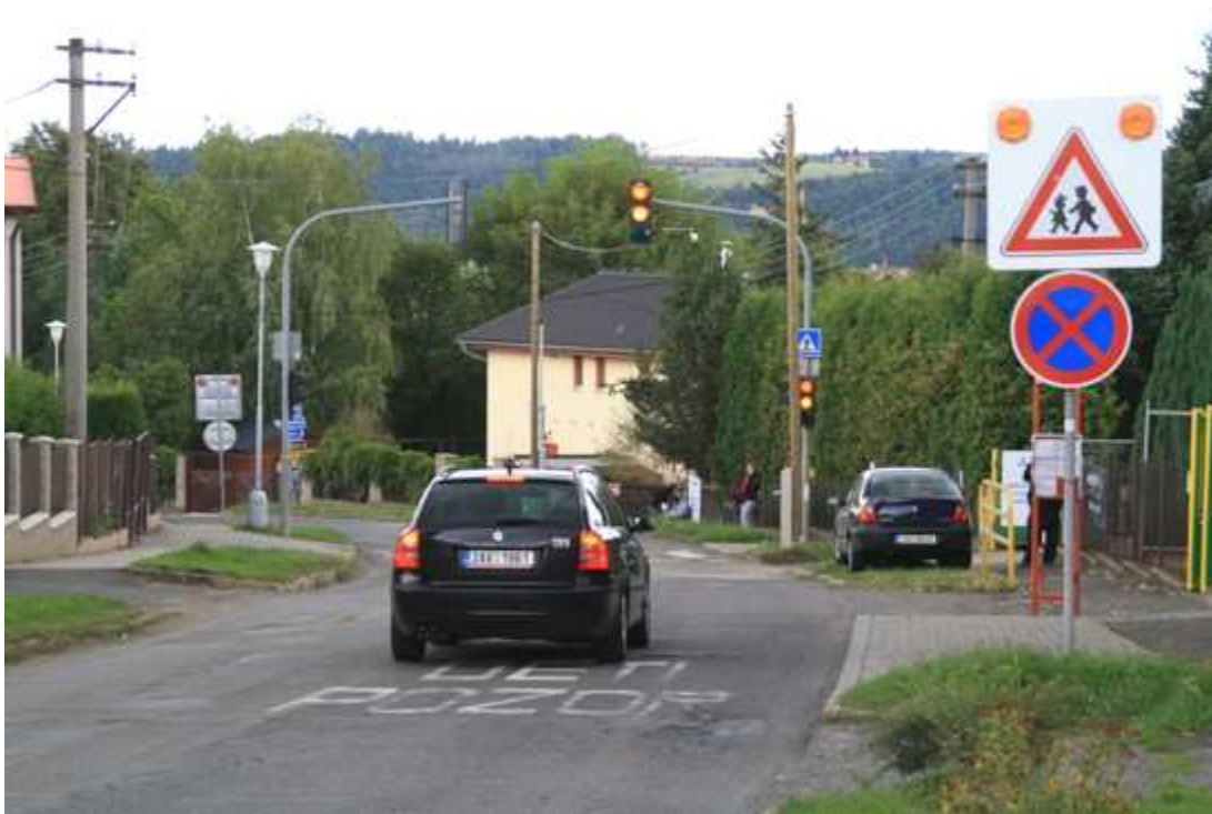
světelná brána není nastavena dle projektu dodavatele signalizace (celočervená svítí pouze 2-3 s, nabýt minimálně 5 s), zařízení se má účinkem
