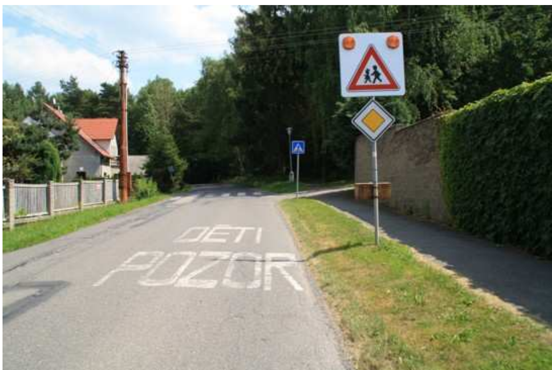
více patrné je upozorňující značení než samotný přechod pro chodce
