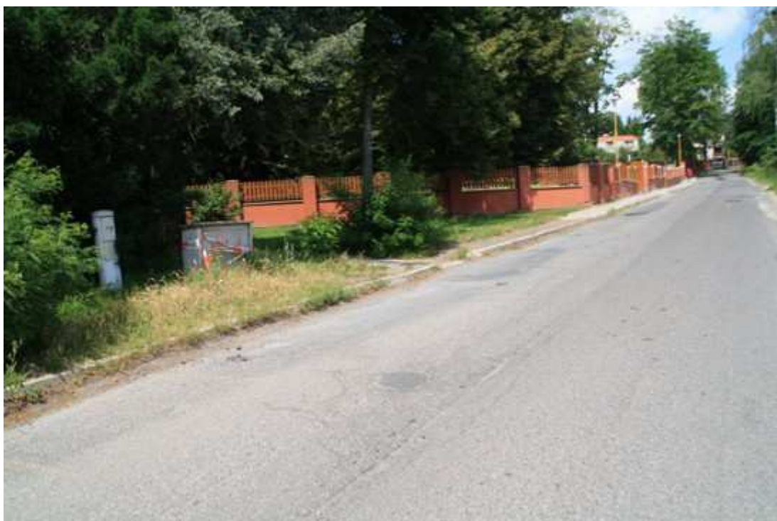
nepřehledné místo, ze kterého přecházejí chodci do ul. Na sídlišti
