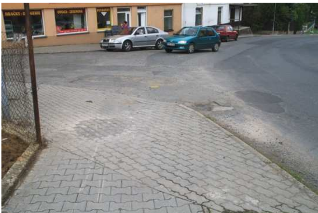
příliš dlouhá vzdálenost pro přecházení přes vjezd do ul. Zahradní, navíc u obchodu vždy parkují vozidla a děti procházejí mezi nimi, rychle jedoucí vozidla vyjíždějící do ul. Zahradní je mohou srazit, neboť mohou jet rychle a nemají přehled
